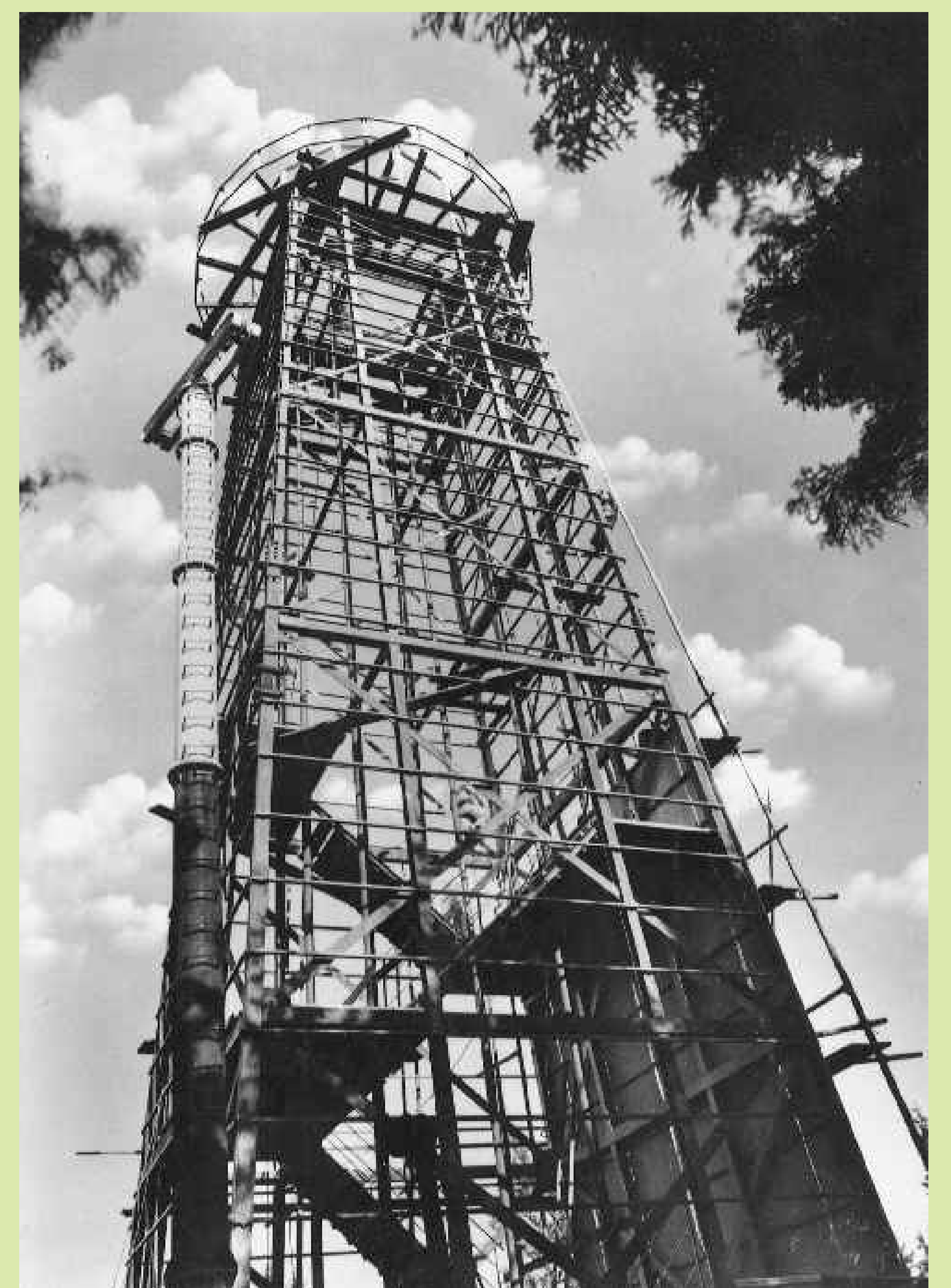
Errichtung der Stahlbaukonstruktion, 1963
